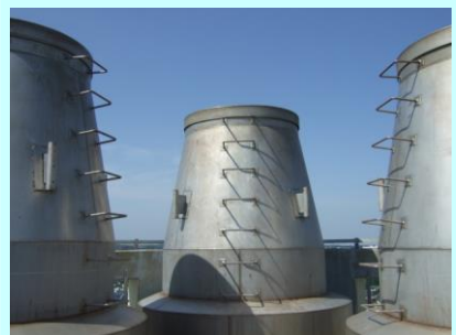
煙突（先端部分）
