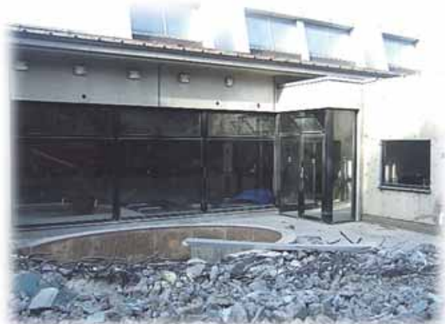
露天風呂の解体
