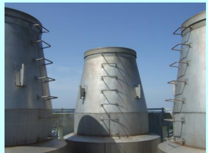
煙突（先端部分）
