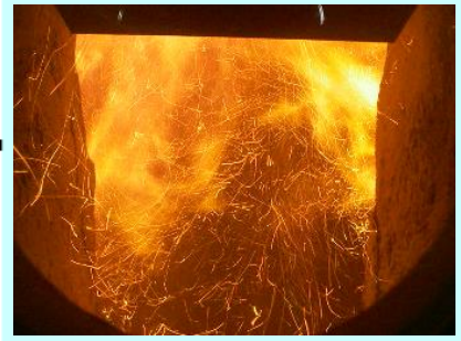
焼却炉内部 (ごみが焼却されている状態)
