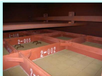
脱硝反応塔（内部）
