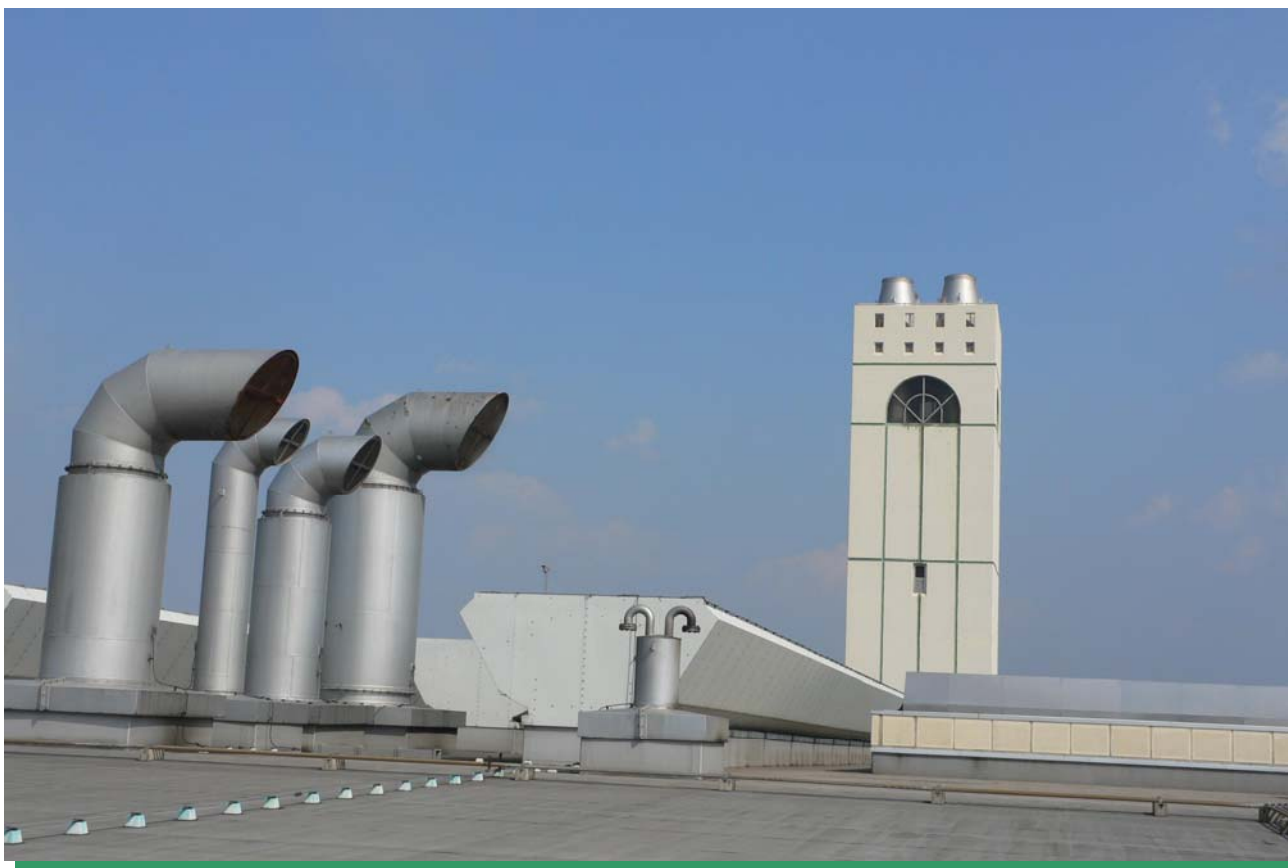
写真 西多摩衛生組合環境センター屋上
