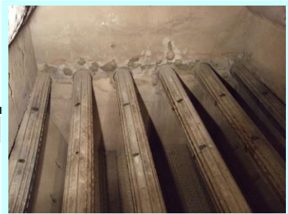
焼却炉内部 (流動砂のない状態)
