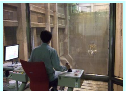
ごみクレーン操作室
