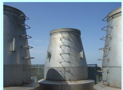
煙突（先端部分）
