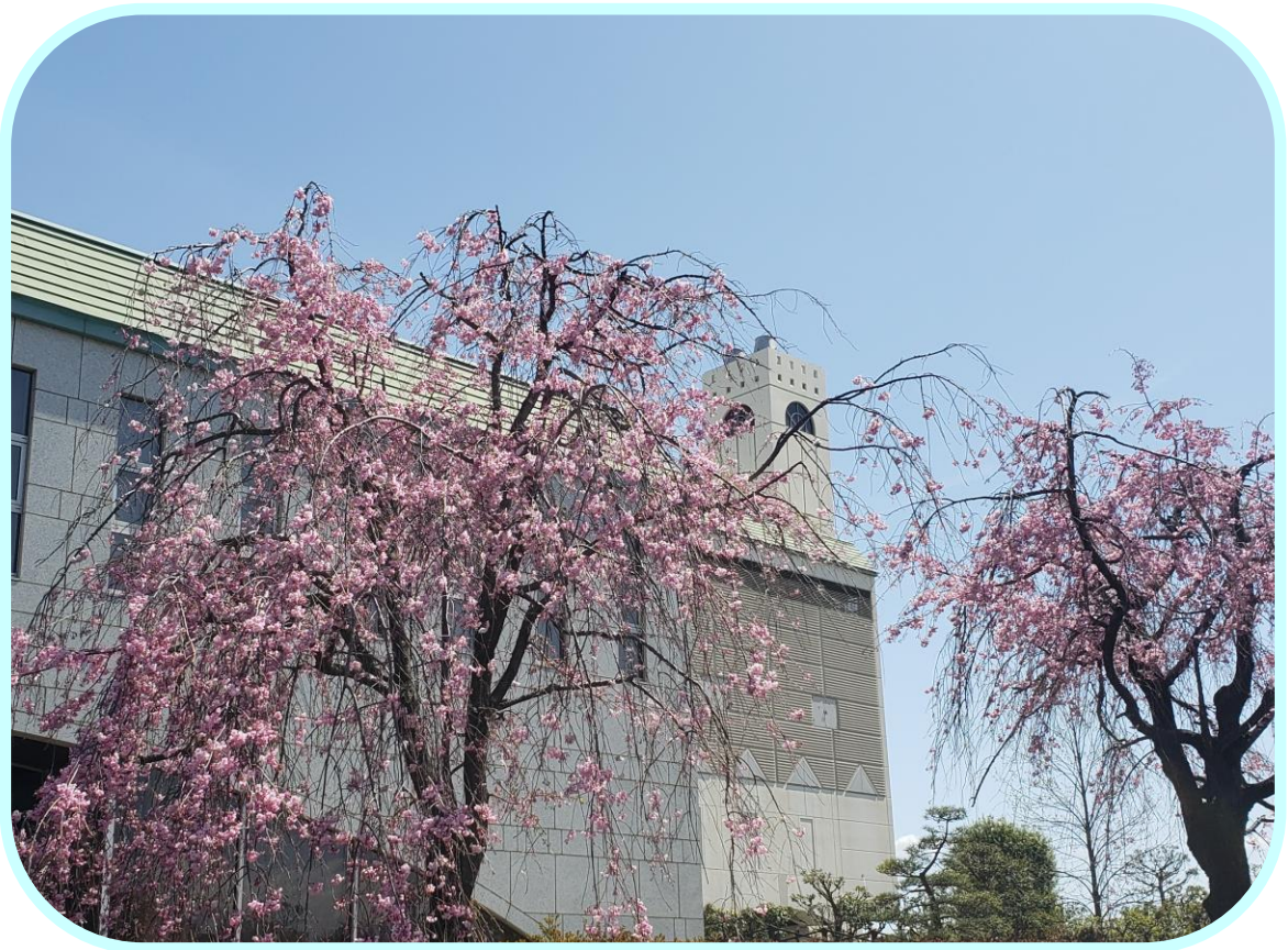
写真 西多摩衛生組合 管理棟正面
