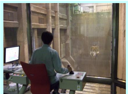
ごみクレーン操作室
