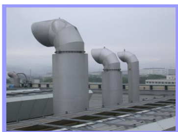
環境センター屋上サイレンサー
