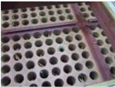
旧バグフィルター抜取り前(2号炉)560本
