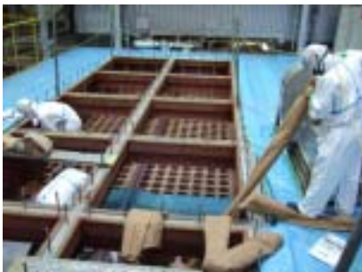
旧バグフィルター抜取り中
