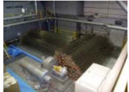
バグフィルターのリテーナー取外し後(560本)
