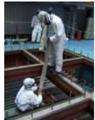
触媒入りバグフィルター取付け中
